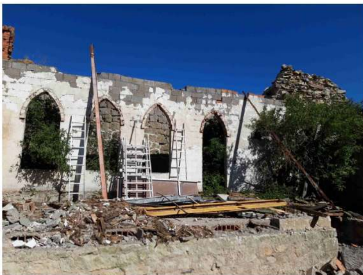
Paño fábrica de bloque
