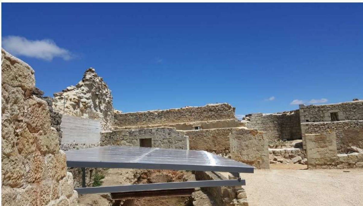
Elemento de cubrición ligera que protege el Aljibe y permite su contemplación sin riesgo de caída.
