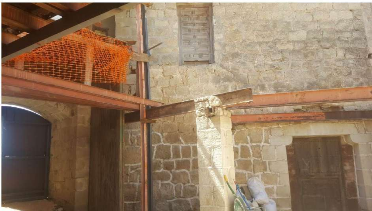
Demolición del forjado que acometía contra la Torre del Homenaje
