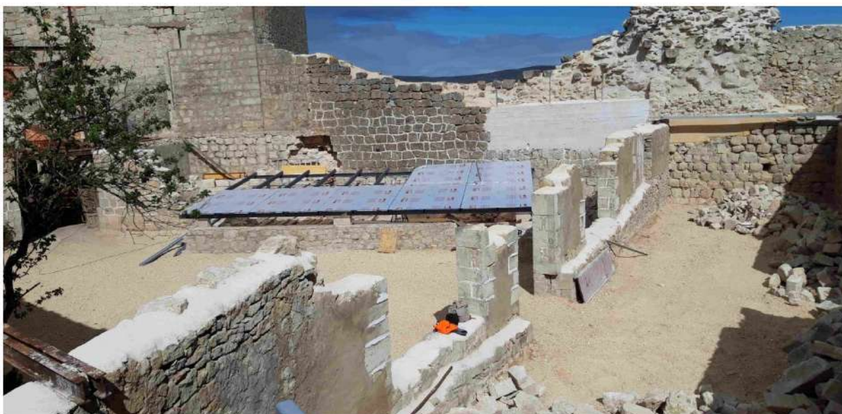
Elemento de cubrición ligera que protege el Aljibe y permite su contemplación sin riesgo de caída.
